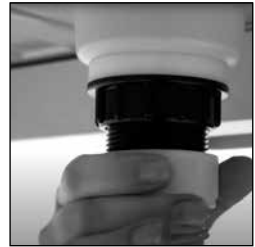
Figuur 23 vervangen afvoerslang.
